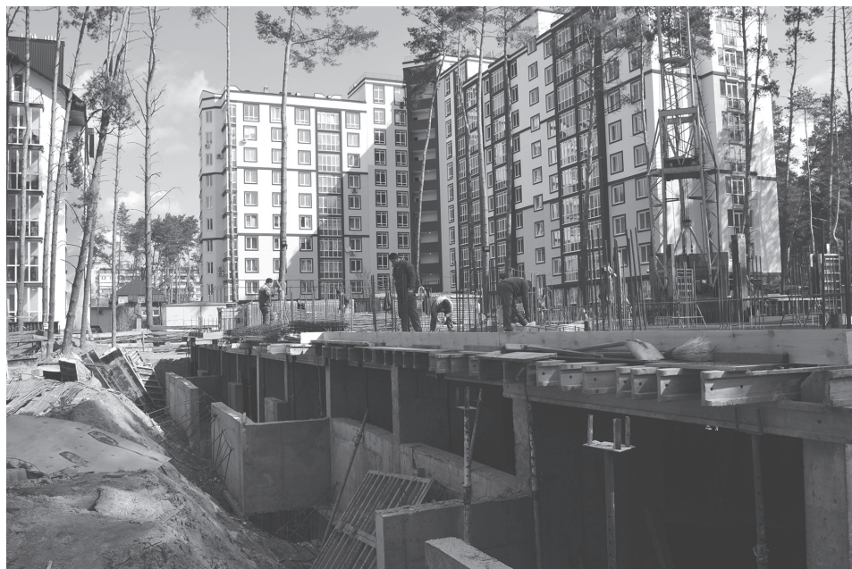
Закладається фундамент під ще одну секцію багатопверхівки.
