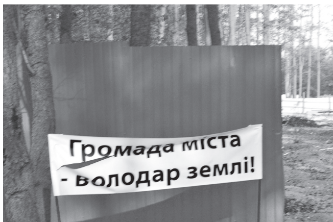
Будівельний майданчик по вул. Єсеніна
